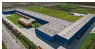
Hörmann Tianjin, Cina
