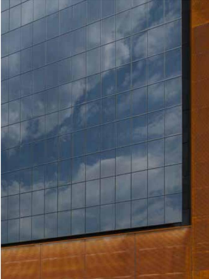
Particolare degli elementi per facciate fotovoltaici con telaio
