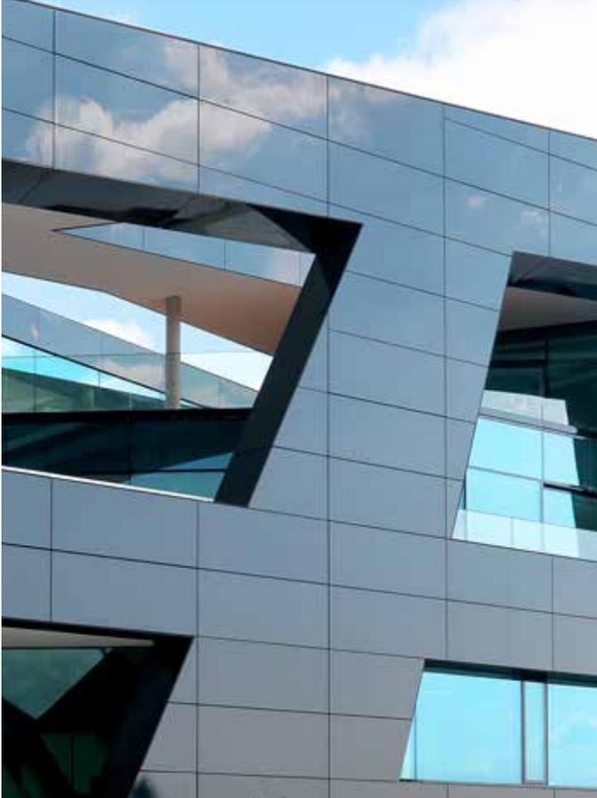
Passaggio degli elementi in vetro neri con fissaggio invisibile e struttura dei giunti aperta verso l'imbotte
