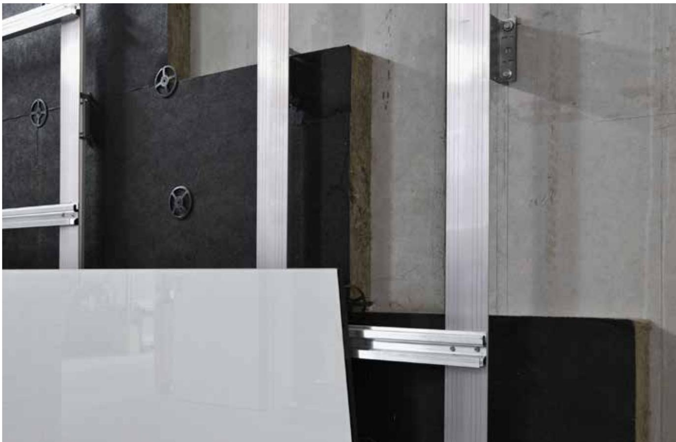
Struttura di sistema StoVentec con sottostruttura in acciaio e alluminio
